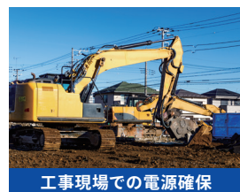
工事現場での電源確保
